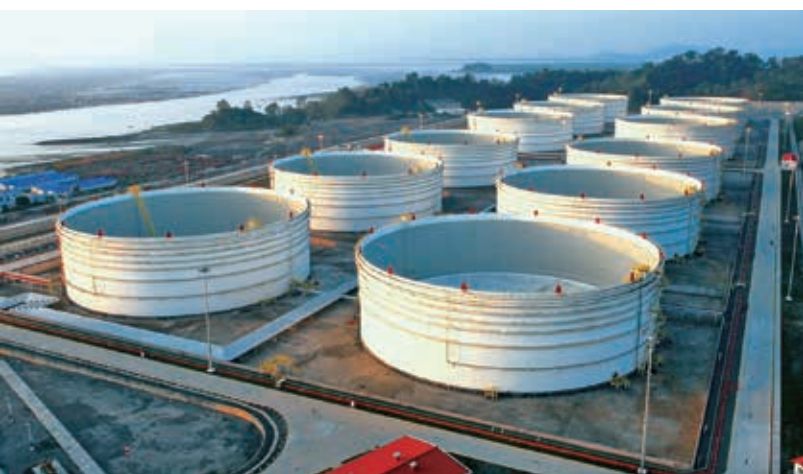
Строительство нефтехранилища на острове Madau в Мьянме
